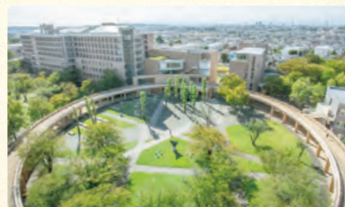
I 府中キャンパスの中央広場を見下ろす
