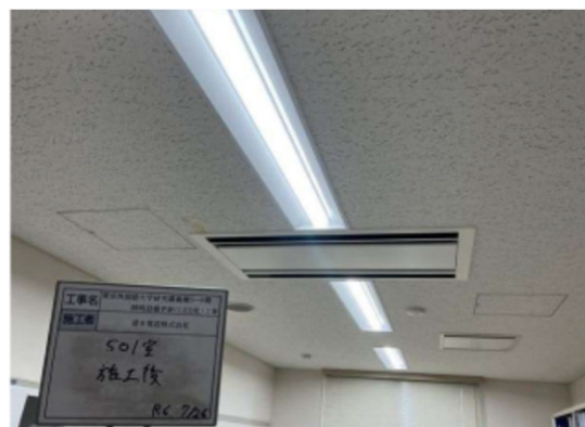
研究講義棟照明LED化改修後（教室）
