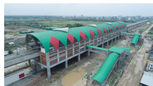
ウットラ中央駅の駅舎
