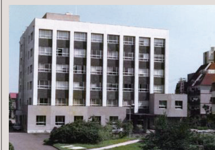
新築の4号館(木造校舎の跡地に建設)
