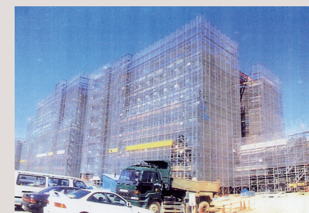
A 研究講義棟(建設中)
