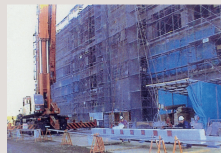
A 研究講義棟(建設中)
